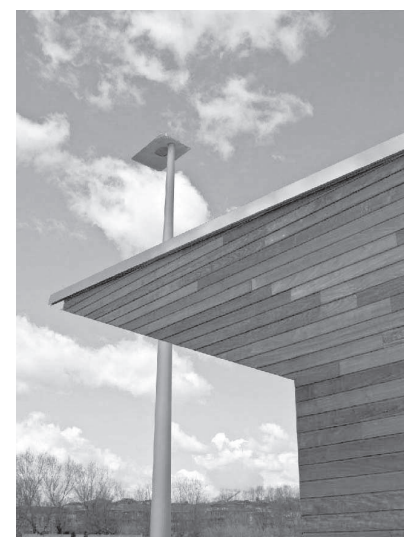
Foto 12: Porto Sant'Elpidio: detalhe da iluminação Fonte: Studio Franco Zagari
