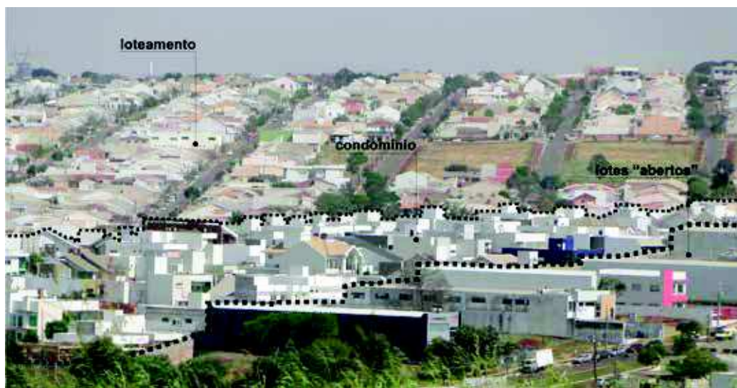
Figura 6 Tecido urbano, Maringá, 2015. Primeiro plano: faixa de lotes “abertos” de uso comercial contígua ao condomínio fechado. Segundo plano: condomínio fechado. Terceiro plano: tecido habitacional resultante de loteamentos.
