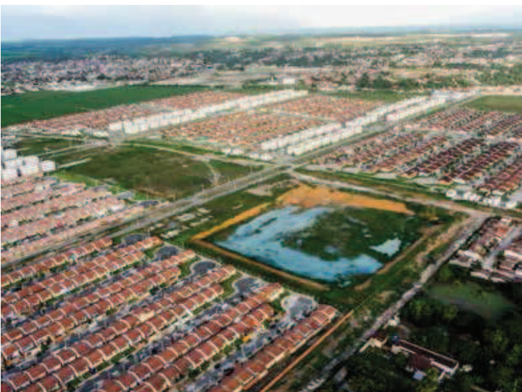
Figura 7b Empreendimentos MCMV no bairro Benedito Bentes. No centro, lagoa de retenção de águas pluviais. Fonte: Jonathas M. Silva, 2ª Oficina Quapá-SEL, Maceió, mai. 2014.
