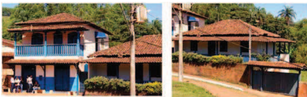
Figura 11 Variações do tipo 1, uso misto e acréscimo de outro andar (à esquerda), e variação do tipo 2, com inserção de varanda (à direita).
