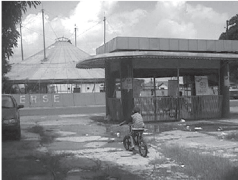
Figura 3. Pontos comerciais, pavimentação destruída, lixo e sujeira, na praça da Integração Fonte: Marta Alves
