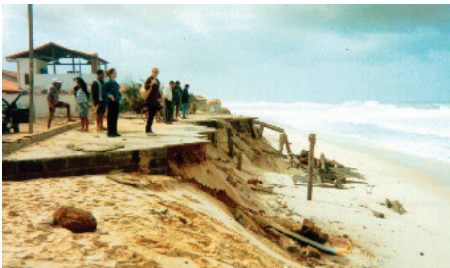
Foto 2: Destruição das construções em 2001
