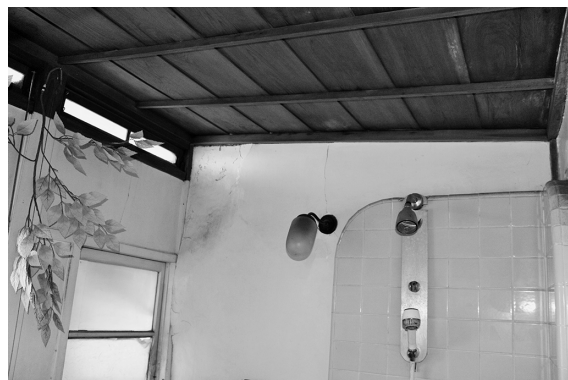
図44 浴室の勾配天井（左上に回転窓）
