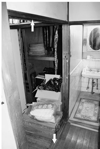
図 56 痕跡②：敷鴨居に残る2本溝（矢印）
