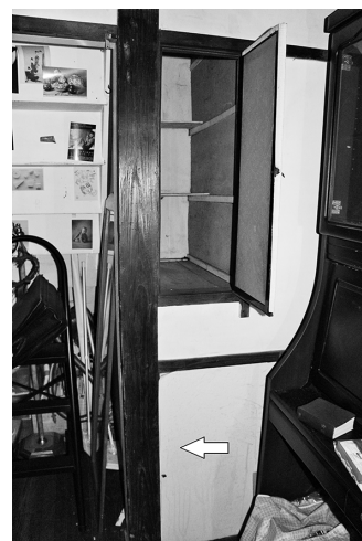
図99 階段室下3畳間の北側：壁面の下部に開き戸（矢印）があり、茶の間に通じる。
