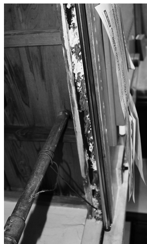
図 59 痕跡⑤：図 58 の柱間の上に漆喰壁が残る。
