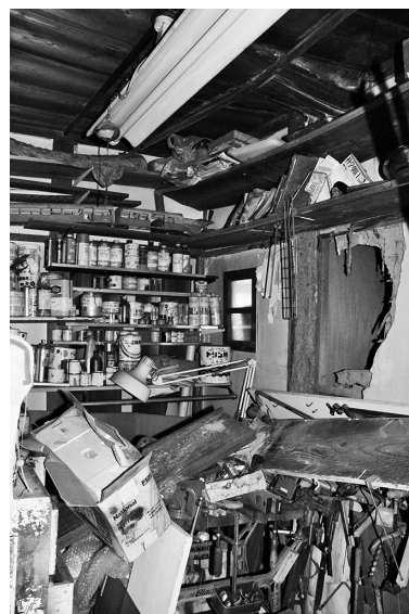
図40 納戸（元女中室、写真中央に覗き窓）
