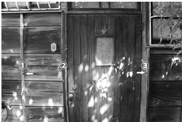
図 63 痕跡⑧：ドア両側の下見板に水切り板の跡（矢印） 押縁①～③のうち、①と③に水切りの痕跡あり。ドアの設置後、①と②を入れ替えたと思われる。
