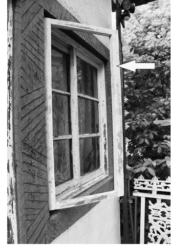
図 72 痕跡⑰：引違い窓の外側に別の窓枠 (矢印) が残る。
