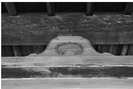
図11 玄関前の梁と水平材の中央にある鬘股
