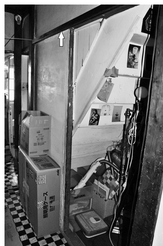
図 66 痕跡⑩：階段横の敷鴨居に1本溝（矢印）
