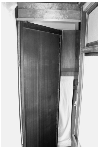
図 75 後補 b: 2階縁側西端 の戸
