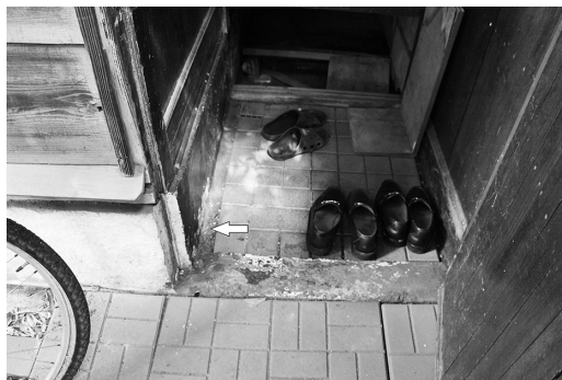
図 64 痕跡⑧：勝手口土間に排水溝（矢印）
