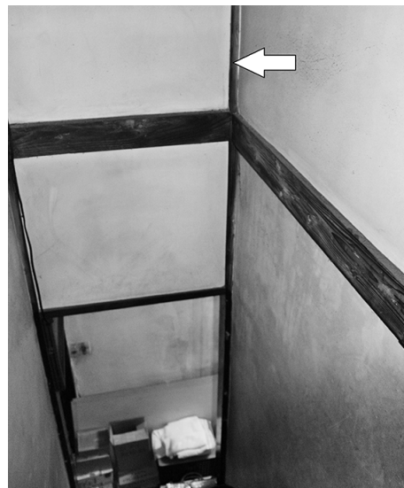
図 82 階段室の通し柱（矢印）
