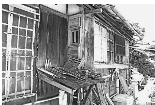
図95 台所の覗き窓（写真中央）を外から見る。
