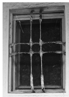
図96 応接室の覗き窓を外から見る。
