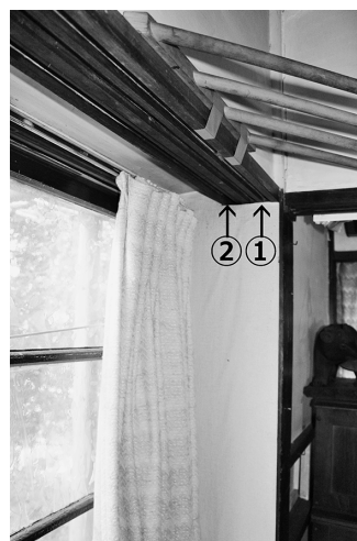
図 68 痕跡⑬：6畳間南側に残る鴨居（2本溝①と1本溝②）
