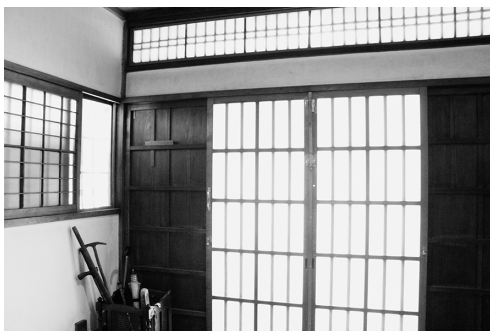
図13 引分け戸の裏側と欄間、雨戸も引分け
