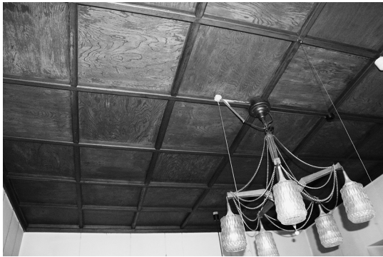
図 17 応接室の格天井
