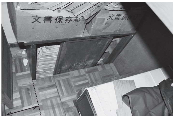
図39 内玄関（現在は板張りして納戸として使用。写真上に下駄箱）（破線と矢印は板張りの下に残る玄関土間の上がり段の位置を示す。）
