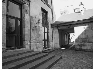
写真10 建物の下の通路から隣の中庭空間に抜けられる。(No. 189)
