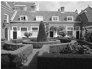
写真11 各住戸が中庭空間を囲むように配置されている。(No. 190)
