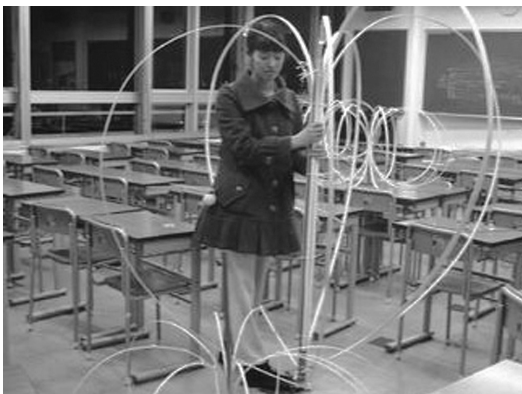
写真 33 ユニット（中）の施工方法検討
