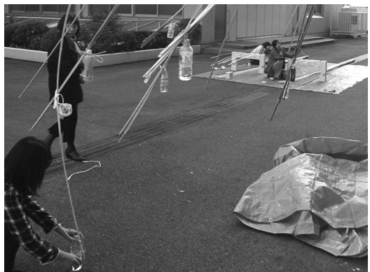
写真22 曲線の癖付け
