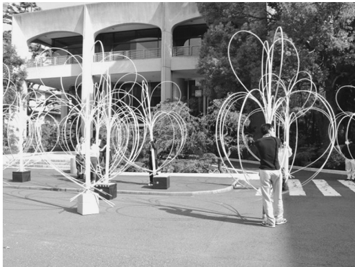
写真 23 パーツ取付とユニット配置作業
