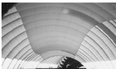
a) エアドーム内観/天井部分は二重膜、遮熱効果は大
