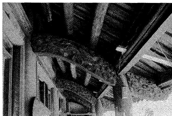
图 6-270 Cao Van Toan 邸 主屋 孫廂架構
