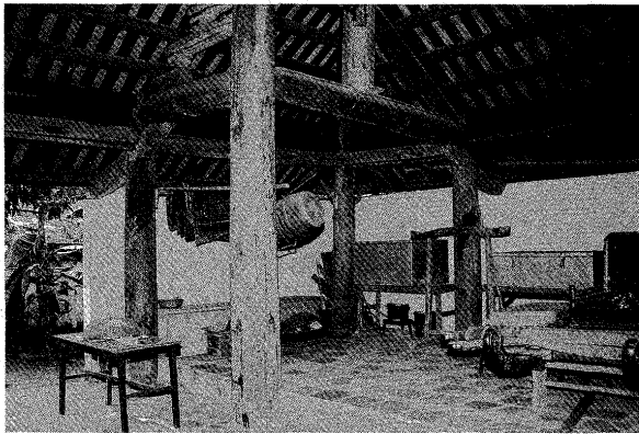
図6-343 フンフン廟 ダイバイ 隅部架構
