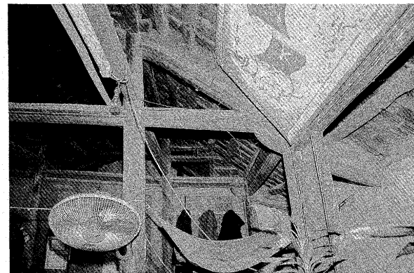
図6-256 Truong Van Quyen邸 廂架構
