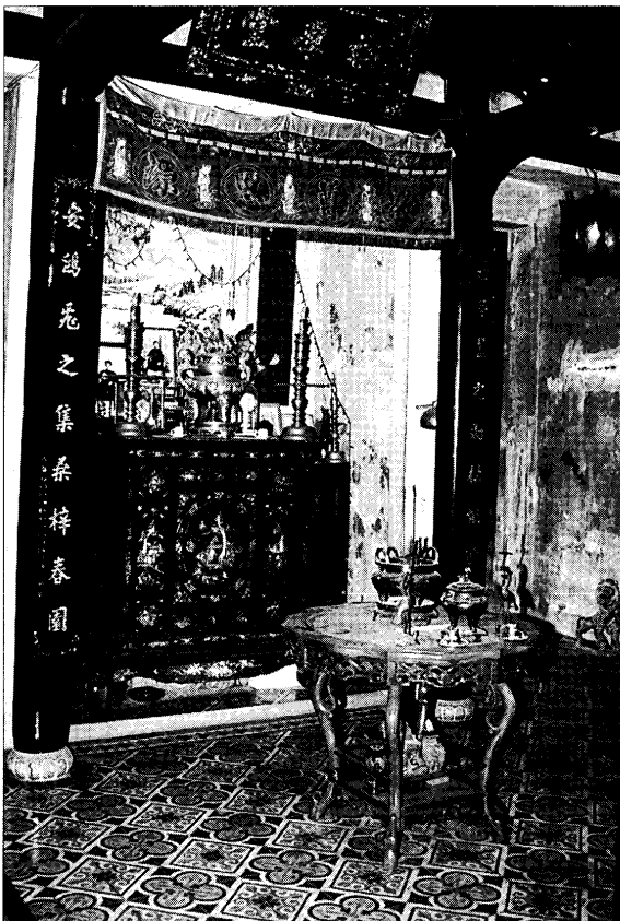
タイホック89番では、改築に当たり、古い建物にあった祖堂とそれを囲む柱や梁を切り取り、そのまま新しい建物の2階へ移した。ホイアンでは新しい建物でもこのような空間が大切にされる。
