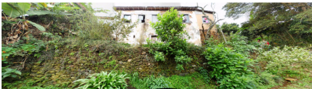
Figura 10 – Vista dos fundos da casa de Henrique Lopes. Foto: Heitor Kooji Mello Matsui e Tatiana de Souza Gaspar, 2014.
