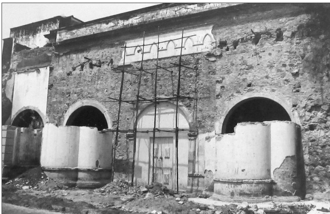
Figura 10 – Fotografia da obra de restauro da Sé de Olinda, em abril de 1974, com retirada das capelas laterais neobarrocas. Autoria não identificada. Acervo da SEPLAN/PR, abrigado na 5ª SR IPHAN. BR – PE.16 (013), pasta 4.
