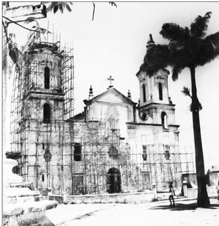
Figura 9 – Fotografia da obra de restauro da Sé de Olinda, em janeiro de 1975, com “desnudamento” da fachada. Fotografia de Narciso. Acervo Fundarpe, pasta 252.
