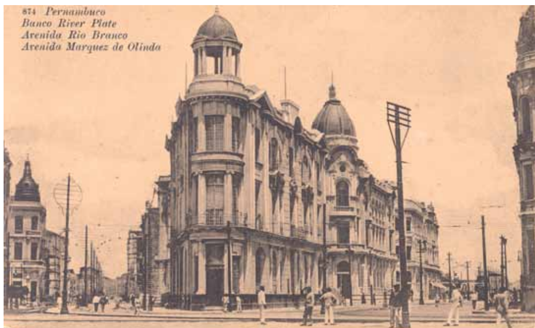
Figura 1 – O edifício Luciano Costa aparece em segundo plano, por trás do prédio do Banco River Plate, ambos situados entre as principais avenidas abertas na reforma urbanística da década de 1910. Cartão-postal. Missiva de 1919. Acervo da Fundação Joaquim Nabuco, Recife.
