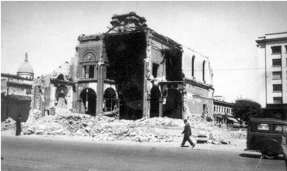
Figura 1 – Demolição da Igreja do Rosário. Campinas, SP, 1956, V-8.
