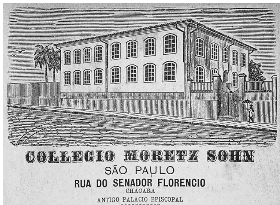
Figura 1 – Sede da chácara de Miguel Carlos (construção: c.1784), depois Palácio Episcopal e mais tarde casa do 1º Barão de Piracicaba. Pouco anos antes de ser demolida, em 1890, essa casa chegou a sediar o Colégio Moretzsohn. Anúncio do Colégio Moretzsohn. Almanach da Provincia de S. Paulo para....1884 . Acervo da Biblioteca do Instituto de Estudos Brasileiros da USP. Reprodução de José Rosael.
