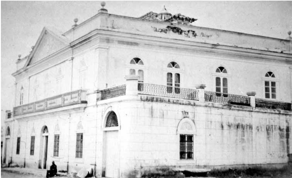
Figura 4 – Casa de José Maria Gavião (construção: 1858-1860). A casa impressiona por seu mau estado de conservação. Foi fotografada, porém, pouco tempo depois de terminada. As grandes manchas visíveis nas superfícies das paredes externas eram consequência direta do clima extremamente úmido então predominante na cidade. Fotografia de Militão de Azevedo, c.1862. Acervo do Museu Paulista da USP. Reprodução de Sérgio Burgi.
