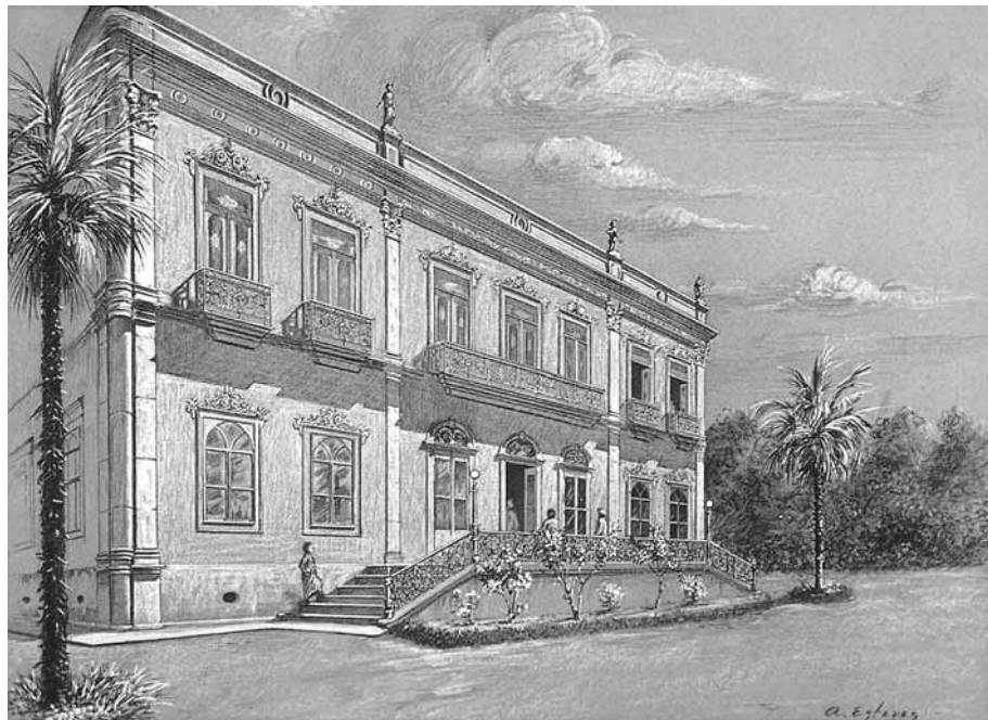
Figura 10 – Palacete de Rafael Tobias de Aguiar, 2º Barão de Piracicaba (construção: 1875 - c.1877). Segundo testemunho de uma das netas do barão, o projeto da casa era de autoria de um francês. Pode até ser verdade, mas o resultado final da construção conservava nítidas características da arquitetura luso-brasileira, mal disfarçadas pelos ornatos de pedra artificial aplicados às fachadas planas. Desenho de Alberto Esteves, 1952. Acervo do Museu da Faculdade de Medicina da USP. Reprodução de José Rosael.
