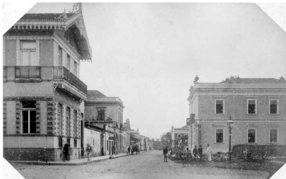
Figura 14 – Vista da Rua Brigadeiro Tobias. À esquerda, chalé de propriedade do então Conde de Três Rios, em construção entre os anos de 1880 e 1881, conforme documentação do Arquivo Histórico Municipal Washington Luís. A autoria dessa construção talvez possa ser atribuída ao empreiteiro italiano Giacomo Gandino, que, alguns anos depois, trabalhava para o conde, tal como prova a mesma documentação. Fotografia de Militão de Azevedo, 1887. Acervo do Museu Paulista da USP. Reprodução de Sérgio Burgi.
