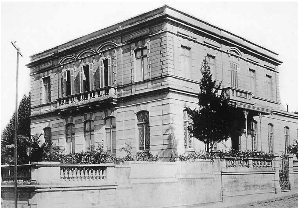
Figura 19 – Casa de José de Vasconcelos de Almeida Prado (construção: 1888 - c.1890). Em seu álbum de realizações editado em 1904, Ramos de Azevedo, de toda a sua produção datada do período imperial, só permitiu passar pelo rigoroso crivo de sua autocrítica as obras que projetou para o governo da Província e apenas dois palacetes particulares, o de José de Vasconcelos de Almeida Prado, visto acima, e o de Antônio Pais de Barros, ambos construídos aproximadamente durante o mesmo intervalo de anos, 1888-1890. A edificação ainda existe e está localizada na Rua Beneficência Portuguesa n. 29. Fotografia de Otto Rudolf Quaas, c.1900. (AZEVEDO, [1904]). Acervo da Biblioteca Central da Escola Politécnica da USP. Reprodução de José Rosael.
