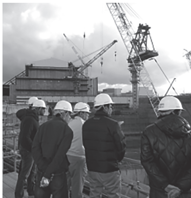
図5 電源開発大間原子力発電所の建設現場視察 (2013年11月)
