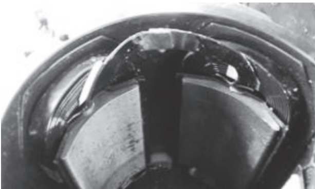
(b) ステータコイルの焼損の様子
