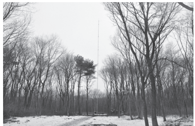
図5 設置された風況観測ポール
