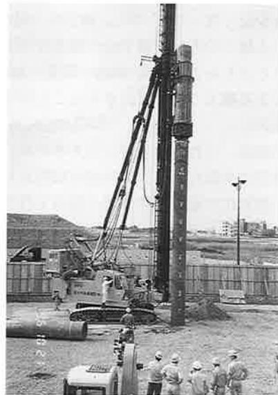
写真-1 鋼管杭の打込試験
