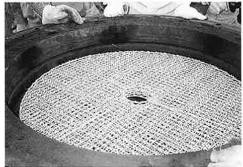
写真-5 細目クッション 5 枚の設置状況
