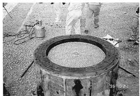
写真-6 細目クッション 10 枚の設置状況
