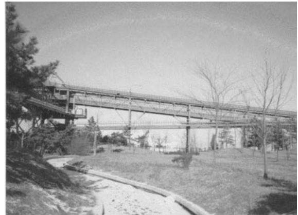
写真-2 地先公園内を通る飼料運搬用コンベア
