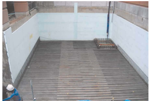
Fig. 3 雪貯蔵庫建設時の状況
