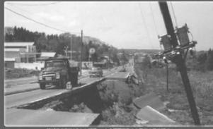
被災地を訪問した際の様子。右上写真は八戸市の被災地で、倒壊した電柱が倒壊した電線を支えている様子。
