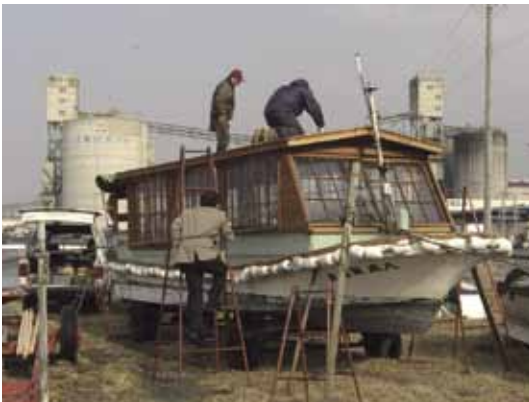
写真1 ソーラー屋形船の改修風景
