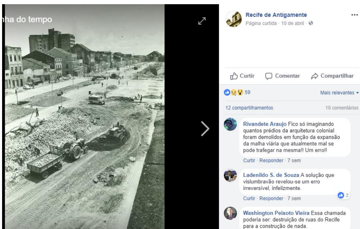
Figura 5 opiniões sobre a construção da Av. dantas Barreto no centro do Recife: “Fico só imaginando quantos prédios da arquitetura colonial foram demolidos em função da expansão da malha viária que atualmente mal se pode trafegar na mesma!! Um erro!!”
