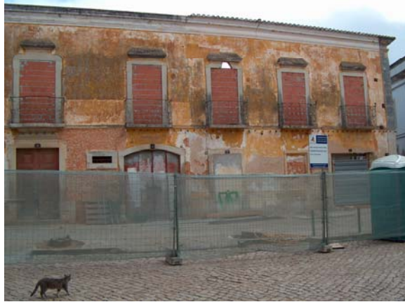
Fachada do edificio antigo
