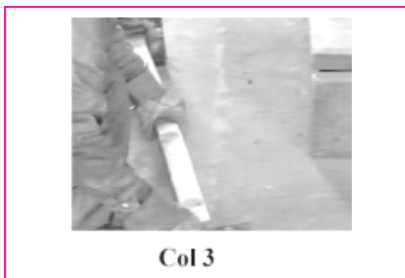
Figura 16. Falla por pandeo local y global de la columna tipo cajón 3.
