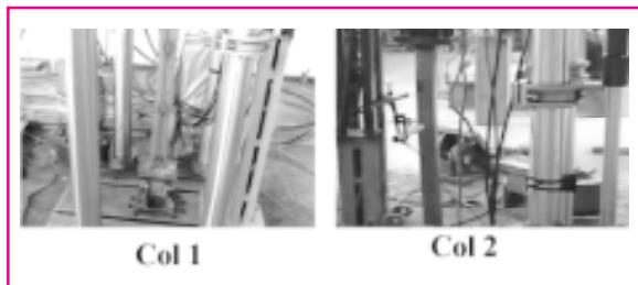
Figura 15. Falla por pandeo global de las columnas tipo cajón 1 y 2
