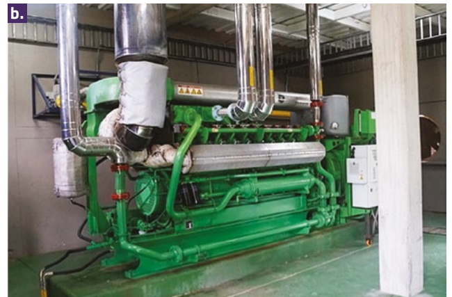
Figura 5. (a) Sistema de generación de energía eléctrica a partir de vapor generado en las calderas. (b) Sistema de generación de energía eléctrica a partir del biogás producido en las lagunas de tratamiento de aguas residuales.
