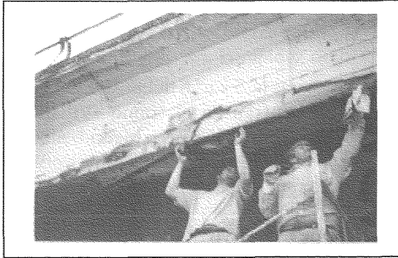
Figura 11 Colocación de las láminas sobre la estructura, puente del Dragó, Barcelona.
