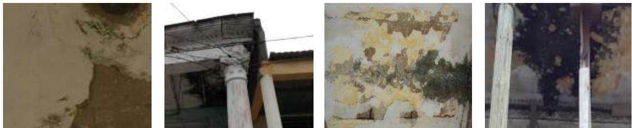
Fig. 4 Ejemplo de deterioros en elementos estructurales de los portales. Fuente: Tomada por los autores
