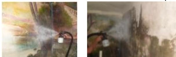
**Fig. 24.** Consolidación y protección mediante el barnizado intermedio.
