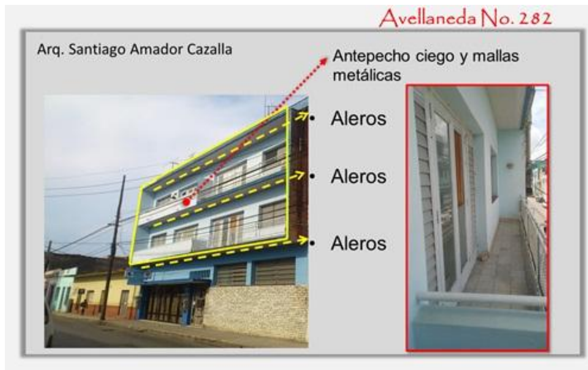
Fig. 8 Geometría de la fachada, con función de protección ambiental Fuente: Fondo digital del CECODEC
