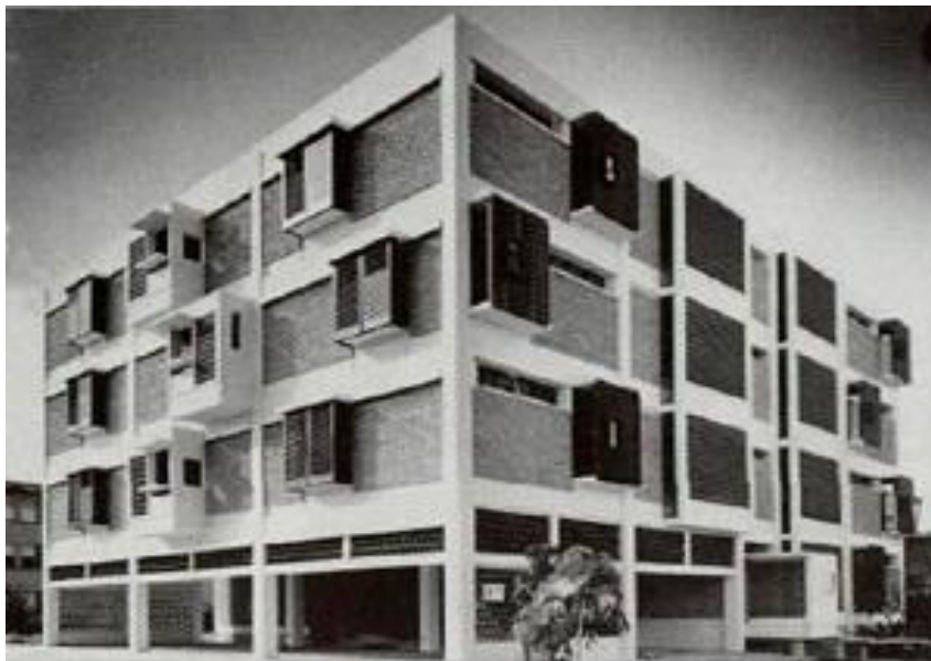
Fig. 1 Edificio de Evangelina Aristigueta de Vidaña, 1956. Miramar. Mario Romañach.
