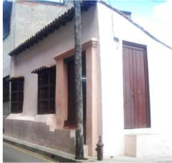
Fig. 6 Alero en la Fachada rehabilitada Fuente: Foto tomada por: Sandra Peña y Yenny Gómez
