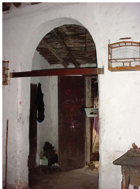
Fig. 5 Arco interior Fuente: Imagen tomada por Gilma Flores
