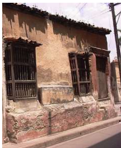
Fig. 2 Zócalo de Fachada antes de la rehabilitación
