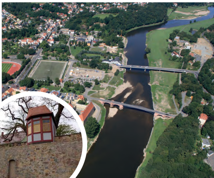
Mulde bei Grimma mit Pöppelmannbrücke Hochwasserschutzmauer mit Gartenhaus in Grimma
