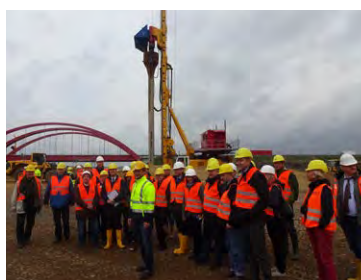
Rüttelstopfverdichtung zur Baugrundverbesserung im Bereich des Hartkanals 2015
