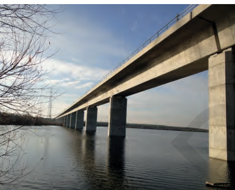
ICE-Neubaustrecke Leipzig/Halle-Erfurt mit Querung des Kieseesees Rattmannsdorf
