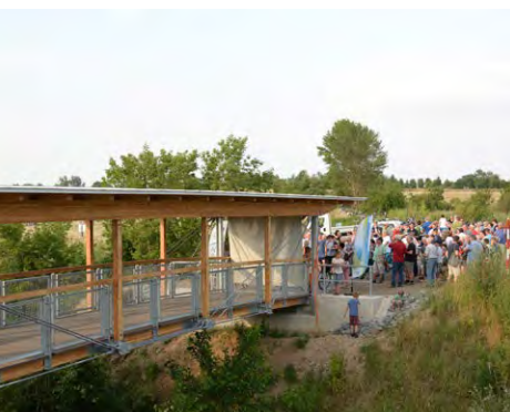
Einweihung der Brücke über den Göselcanyon 2017 – © LMBV mbH (Martin Klindtworth)
