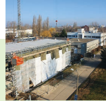
Umfangreiche Baumaßnahmen haben die Jahre 2011–2012 geprägt
