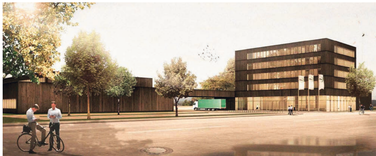
Ansicht des DBFZ-Neubaus aus der Perspektive der Torgauer Straße (stadteinwärts)
