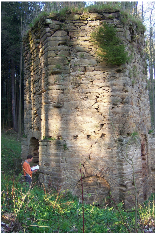
Abb. 32: Turmkalkofen von 1843, Vorkommen Klatschmühle bei Neunzehnhain, 2006 (Foto: G. SACHSE)
