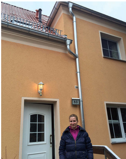
Das Mauerwerk in ihrem Haus wollte Anja Spangberg garantiert trocken bekommen. Das ist geschafft. Sogar der muffige Geruch war nach vier Wochen dank patentierter Technik völlig verschwunden.
