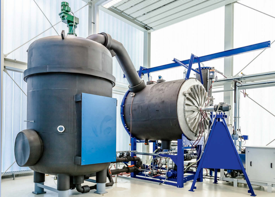
Dieser Vakuumeisspeicher ist eine Pilotanlage innerhalb des Kältenetzes der Westsächsischen Hochschule Zwickau.
