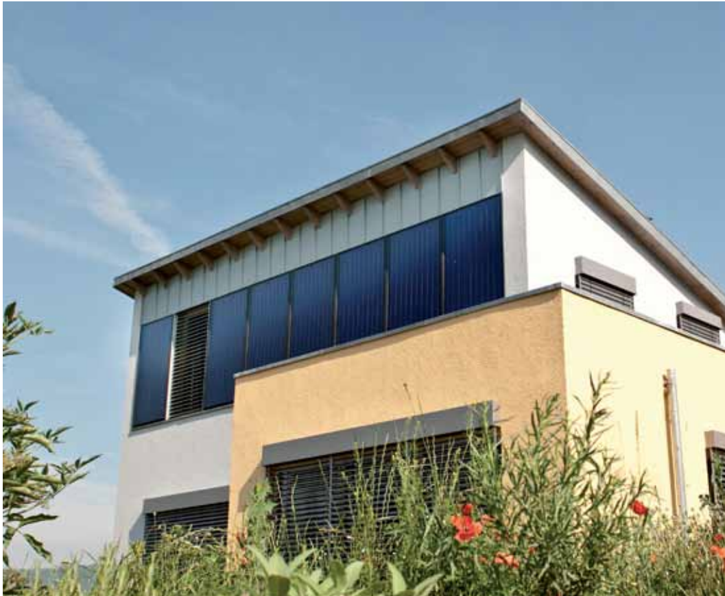
Architekturhaus mit Solarthermie-Kollektor.
