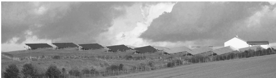
Abb. 1: Solarfeld auf einer ehemaligen Deponie (Foto: Walz 2012)
