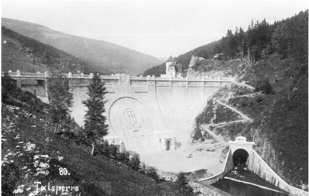
Abb. 10: Die 1910–1915 erbaute Elbe-Talsperre auf einem Foto vor 1925 mit den steinernen Initialen F. J. I. (Franz Joseph I.) Hinter dem Damm das zu Ochsengraben gehörende turmartige Wächterhaus (Nr. 92). Links unter der Krone der Überlauf (siehe Abb. 44 auf S. 105).
