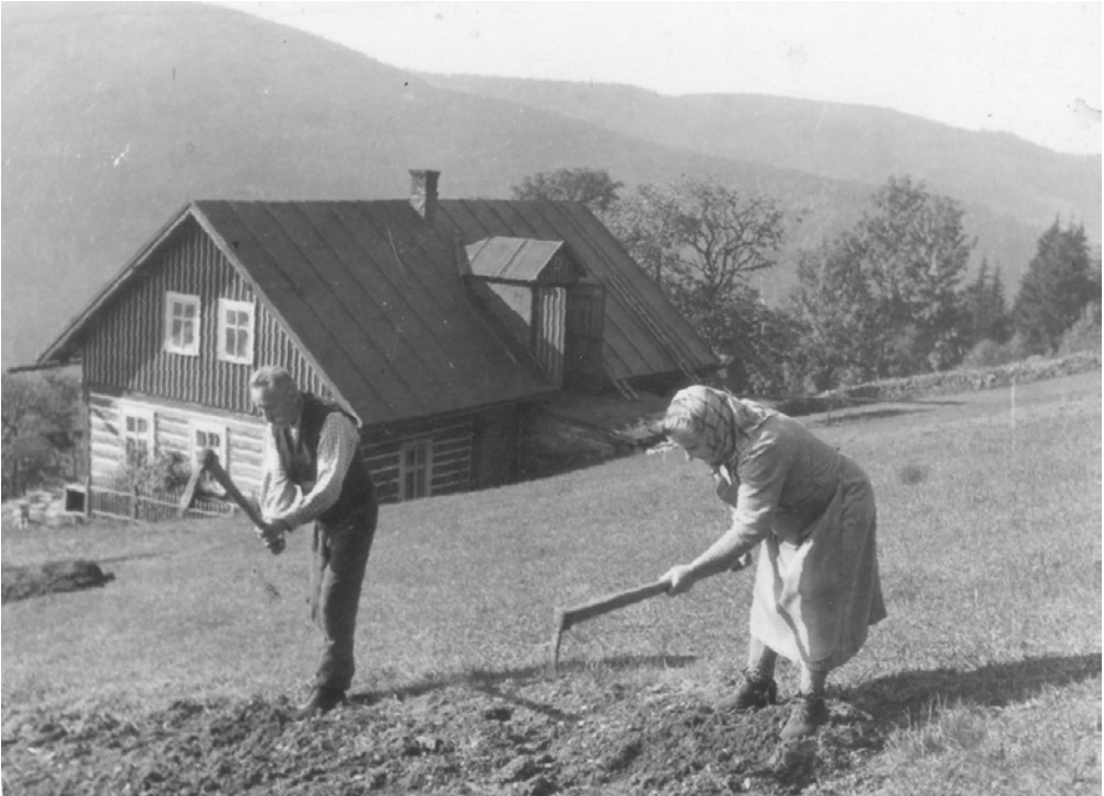
Abb. 9: Der Kartoffelacker wird gehackt. Das ältere Ehepaar, die Frau mit dem typischen Kopftuch und vorgebundener Schürze, besorgt dies in mühevoller eigener „Handarbeit“. Das in Blockbauweise errichtete Wohnstallhaus besitzt zum Einbringen des Heus an der Hangseite eine Brücke, die direkt auf die Binn, den Heuboden, führt. Die sonnige Südseite ist der guten Stube, dem Wohnzimmer des Gebirglers, vorbehalten; vor den beiden Fenstern befindet sich ein kleiner Blumengarten. Das Dach ist mit Teerpappe gedeckt. Man blickt vom oberen Hackelsdorf über das Elbetal hinüber zum Heidelberg-Massiv. – Foto Roland TANNHÄUSER, um 1948.
