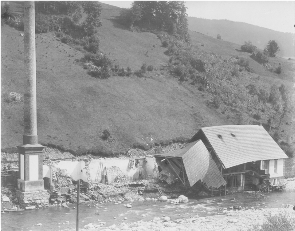
Abb. 4: Das Jahrhundert-Hochwasser der Elbe am 29. Juli 1897 hatte sich tief in die Erinnerung unserer Vorfahren eingepreßt. Die Zerstörungen durch die immer wieder auftretenden Hochwasser – im Bild die 1897 weitgehend vernichtete Papierfabrik der Brüder NETTL – führten zur aufwändigen Regulierung des Wildwassers (1897–1905) und schließlich zum Bau der schützenden Talsperre (1910–1915) im Grenzbereich der Gemeinden Ochsengraben, Krausebauden und Spindelmühle.
