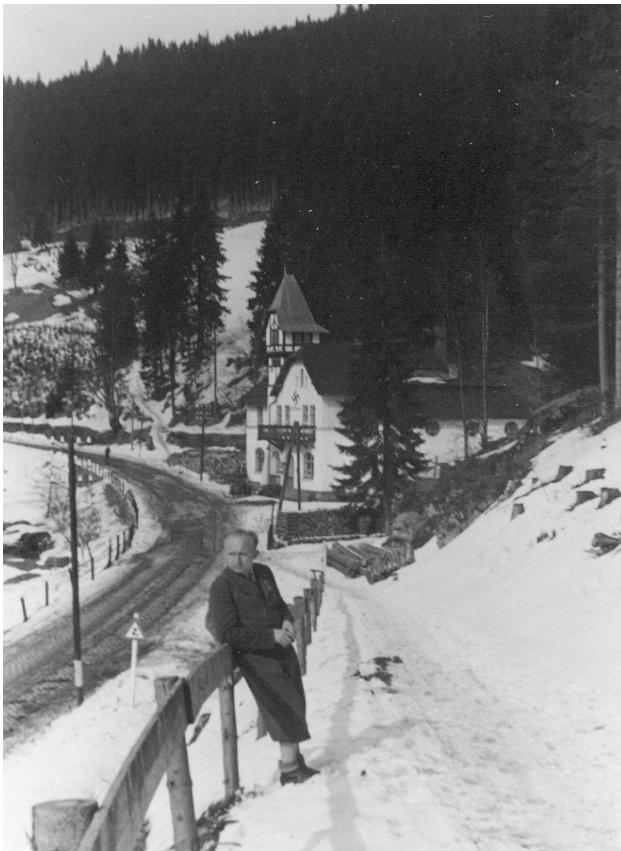
Abb. 61: Ein milder Wintertag um 1938 an der Michelmühle. Hier mündet der über den Mühlberg führende breite Weg, der hinauf in die Oberbauden und andere Ortsteile zieht. Die Mündung des Kläuselbaches ist von der Bezirksstraße überbaut. Man hat eine Menge Langholz („Klötzer“) und Scheitholz mit Schlitten abgefahren und an der Straße zu beiden Seiten des Gebäudes gestapelt. Damals trug man gern Knickerbocker
