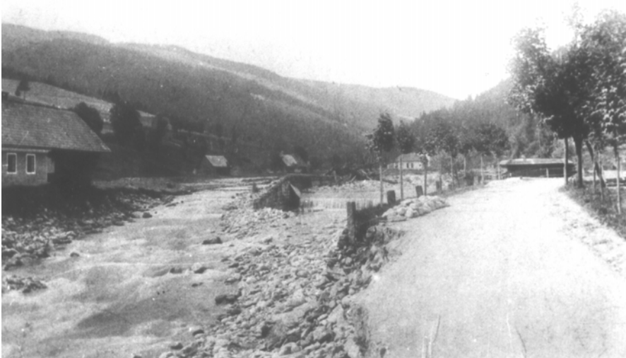
Abb. 40: Hochwasserschäden 1897. – Westlich des demolierten oberen Rotter-Wehres (Bildmitte) hat sich der Fluß durch die Wiesen des GOTTSTEIN-Bauers (Nr. 60) ein neues Bett gegraben, der alte Flußlauf vor der unteren Hackelsdorfer Schule (im Mittelgrund hinter den Straßenbäumen) liegt nahezu trocken. Ganz links das halb weggerissene Haus von Ignaz GOTTSTEIN (Timpel-Tischler; Oberhohenelbe Nr. 95).
