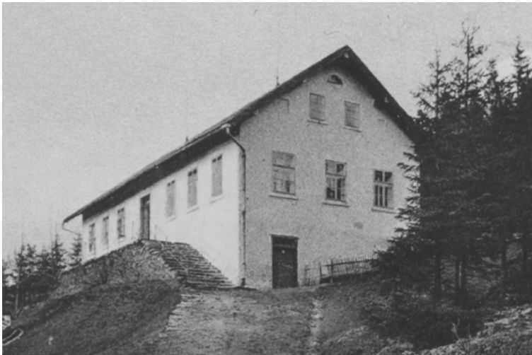
Abb. 14: Die 1884 neu erbaute, im Herbst 1885 in Betrieb genommene obere Schule von Hackelsdorf lag an steilem Hang am Rande des Waldes. Von der steinernen Freitreppe hatte man einen herrlichen Blick über das Elbtal hinüber zum Heidelberg und hinein ins Herz des Gebirges. – Foto um 1910, s. auch Abb. 11.
