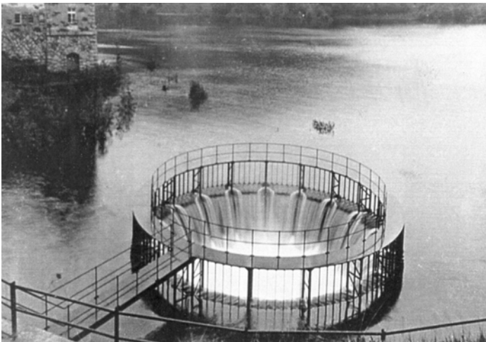
Abb. 9: Der Notablauftrichter während des Hochwassers am 17. August 1930, als zum erstenmal seit ihrem Bestehen die Talsperre vollständig gefüllt war und die Wassermassen sogar durch die Notöffnungen unterhalb der Dammkrone abströmten (Abb. 44 auf S. 105). Links oben ein Teil Wächterhauses, dahinter der steinere Damm.
