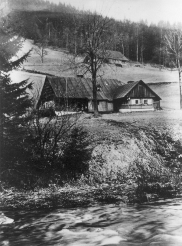
Abb. 62: Das Haus Nr. 48 in den Dreihäusern gehörte dem Johann KRAUS, das höher gelegene am Waldrand (Nr. 49) dem Zimmermann und Kleinlandwirt Gustav BUCHBERGER. Die Wiesengrundstücke sind durch Steinmauern gegeneinander abgegrenzt; die Steine stammen noch aus der Rodungszeit um 1830. Im Vordergrund die Elbe; der über den Fluß führende Holzsteg lag rechts, außerhalb des Bildes. Vgl. dazu die Ortskarte (Abb. 2 auf S. 8). – Foto um 1935.
