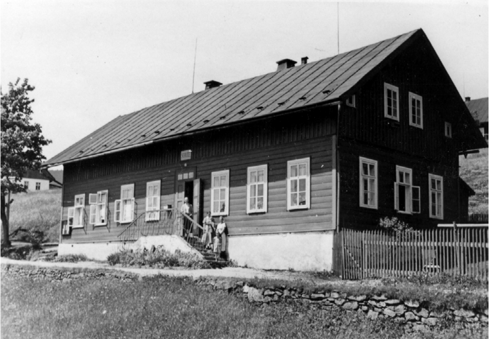
Abb. 15: Die Schule in Ochsengraben (Nr. 21). Der Wille der Bevölkerung, ein Schulhaus mitten im Ort und nicht an der Gemeindegrenze unten im Elbtal zu errichten, hatte sich in einem zweiten Anlauf 1877 schließlich durchgesetzt. – Foto nach 1934.
