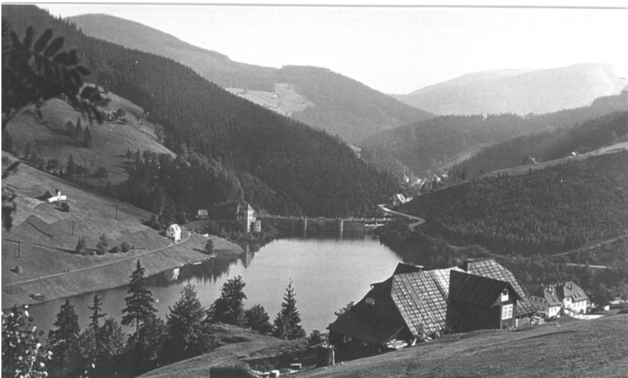
Abb. 58: Blick von Hinter-Krausebauden über die Talsperre auf den Bauernberg (links über dem Einschnitt des Tafelbaches) und einige Bauden des Klausenberges (im Hintergrund, ganz von Wald umrahmt). – Foto um 1940.
