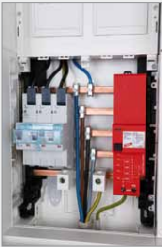
Schützt die Zweidrahtanbindung für DSL und Telefonie
