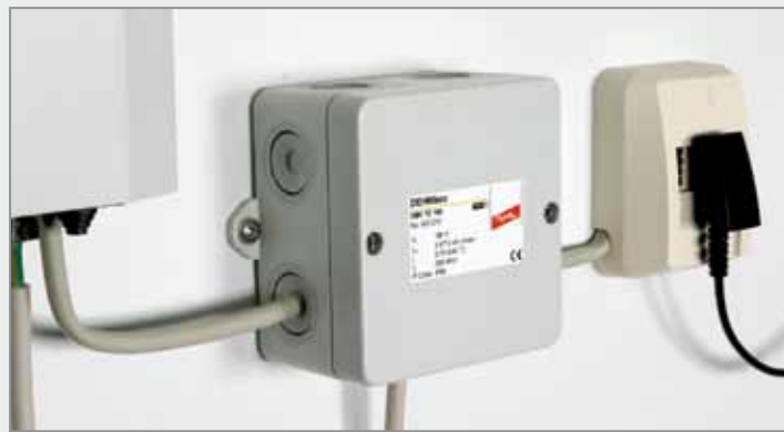
Schützt die Zweidrahtanbindung für DSL und Telefonie
