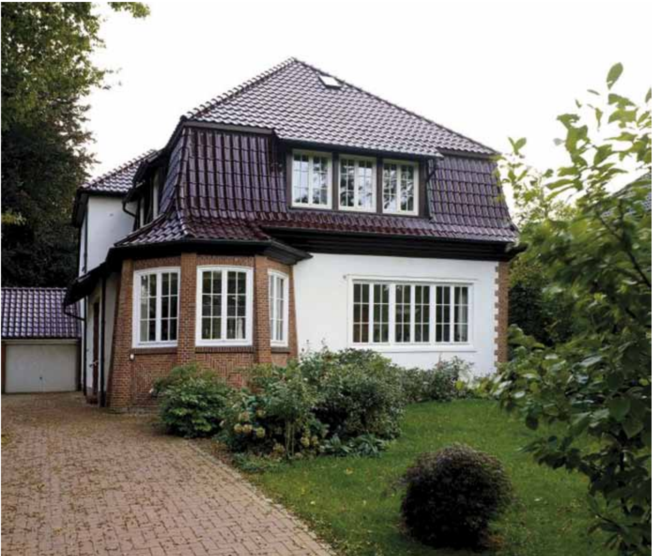
Ein gepflegtes und regelmäßig gewartetes Dach erhöht den Wert der Immobilie.
