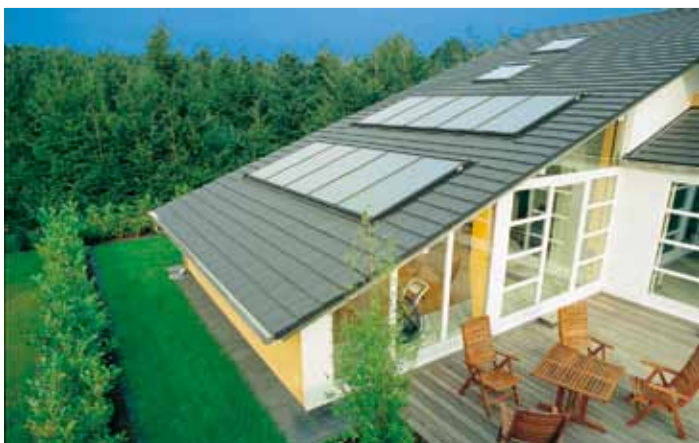
Thermokollektoren liefern Warmwasser und unterstützen beim Heizen.
