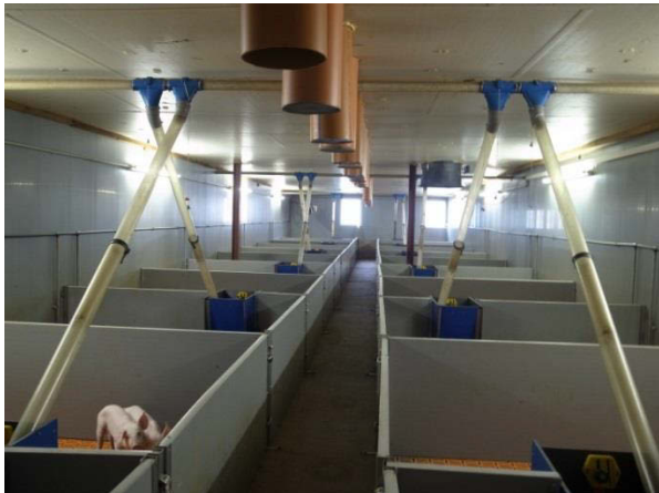
Abbildung 21: Zuluftführung (links: Stall 4; rechts: Stall 2)
