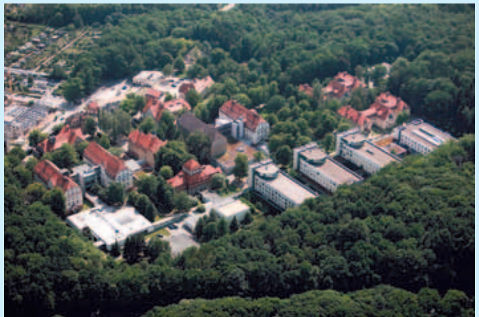
Klinikum Chemnitz, Standort Küchwald im Juni 2008, das Parkhaus befindet sich noch im Bau. Foto: Thieme
