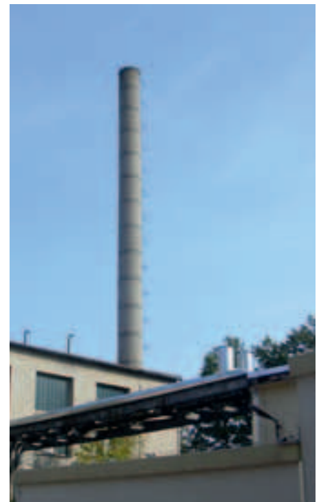
Das alte Heizhaus mit dem zu DDR-Zeiten erreichten Schornstein aus Betonfertigteilen, der nach der Umstellung der Wärmeversorgung auf Fernwärme überflüssig wurde und inzwischen abgerissen ist. Foto: Kreißig, MA/ÖA
