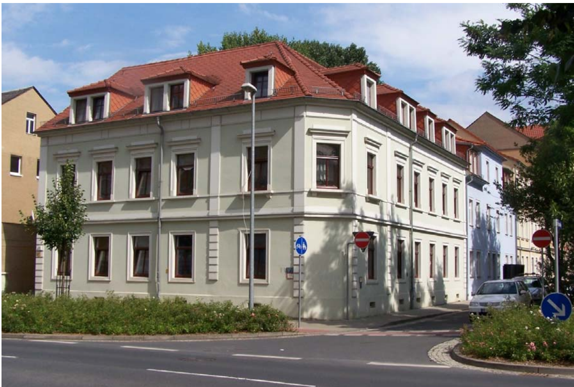
Blick auf die Wohnbauten des ehemaligen Meißner Bauverein – heute Privatbesitz. Foto von 2009 nach der Sanierung (Foto Archiv Löwel)
