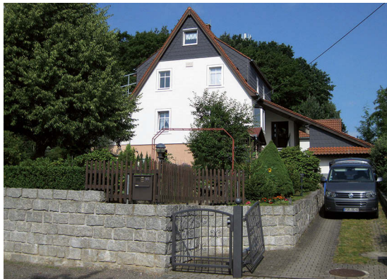
Um Wände und selbst den Kellerfußboden seines Hauses in Weixdorf auf Dauer trocken zu bekommen, investierte Andreas Lindemann in eine patentierte Anlage. Die Feuchtigkeitswerte sanken spürbar und zügig.
