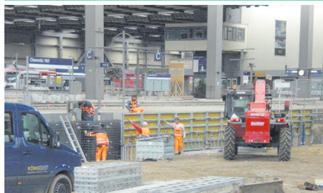
Im Chemnitzer Hauptbahnhof entstand die neue Stützmauer. Foto: VMS
