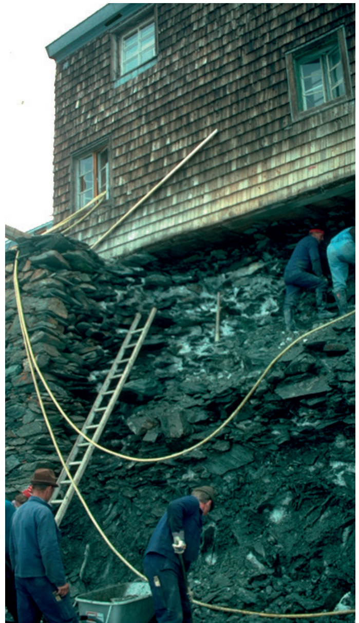
▲ Stabilisierungsarbeiten im auftauenden Permafrostboden an der Alpenclubhütte Adlersruh (3.400 m) am Großglockner in Tirol
