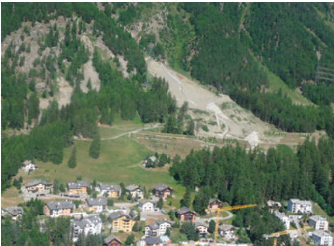
Lawinerverbauung oberhalb von Pontresina
