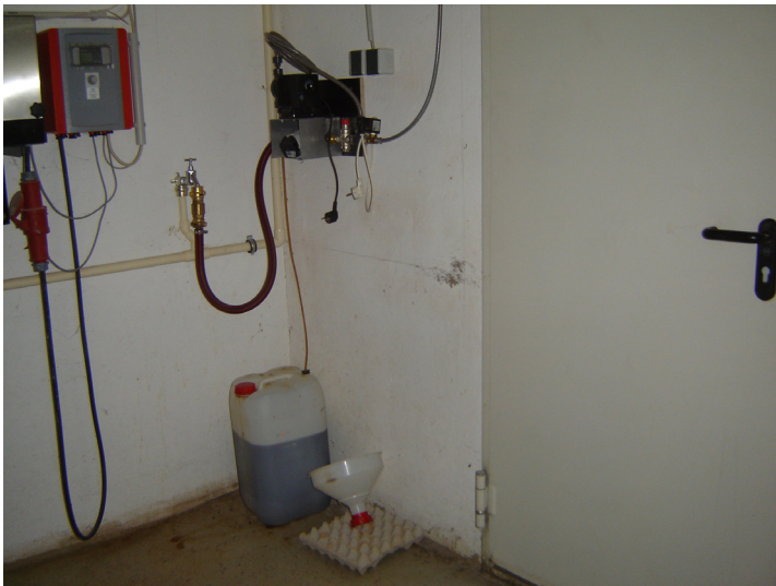
Abbildung 14: Steuer- und Applikationseinheit mit Vorratsbehälter und Zuführung zur Förderschnecke im Stall
